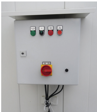
Schaltschrank mit Anschluss an technische Lüftung
