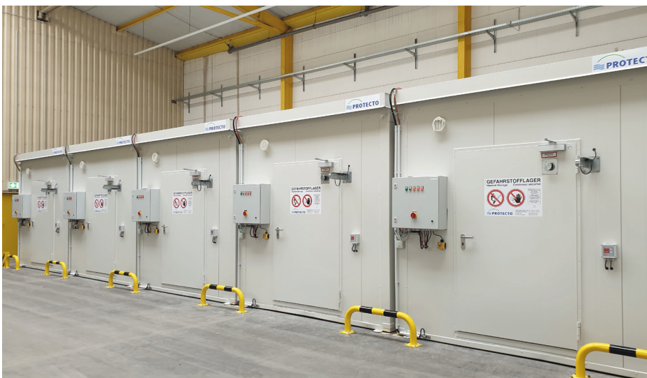
Verbringung und Aufstellung von insgesamt fünf Brandschutzlagern aus Stahl begehbar
